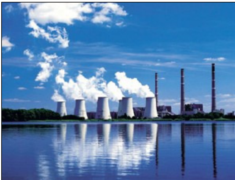
Figur 8: Kraftverket Jämschwalde Tyskland. (foto Vattenfall)
